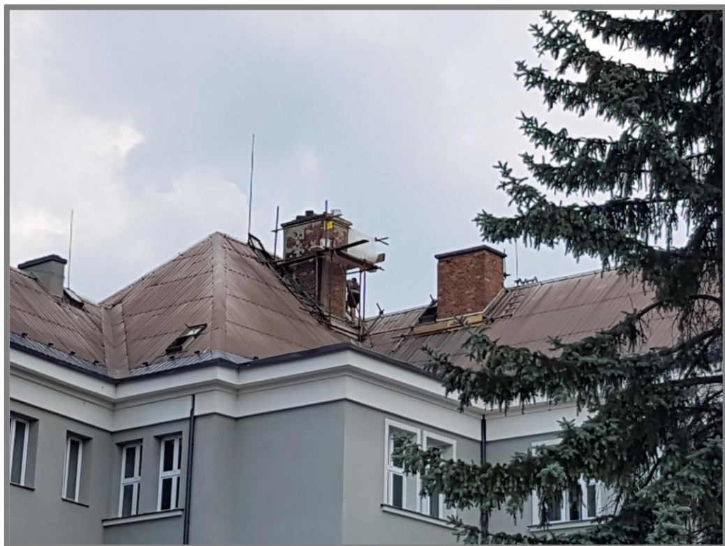
Oprava a demolice komínů
