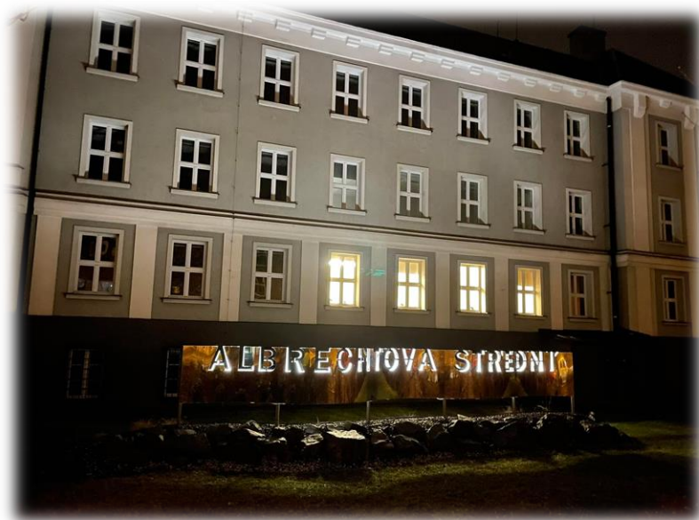
Hlavní budova školy
